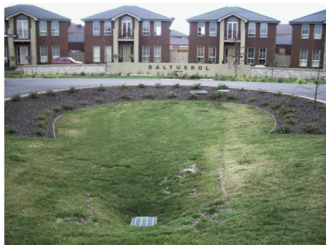
Figura 14 - Poço de infiltração (Fonte: SÃO PAULO, 2012)
